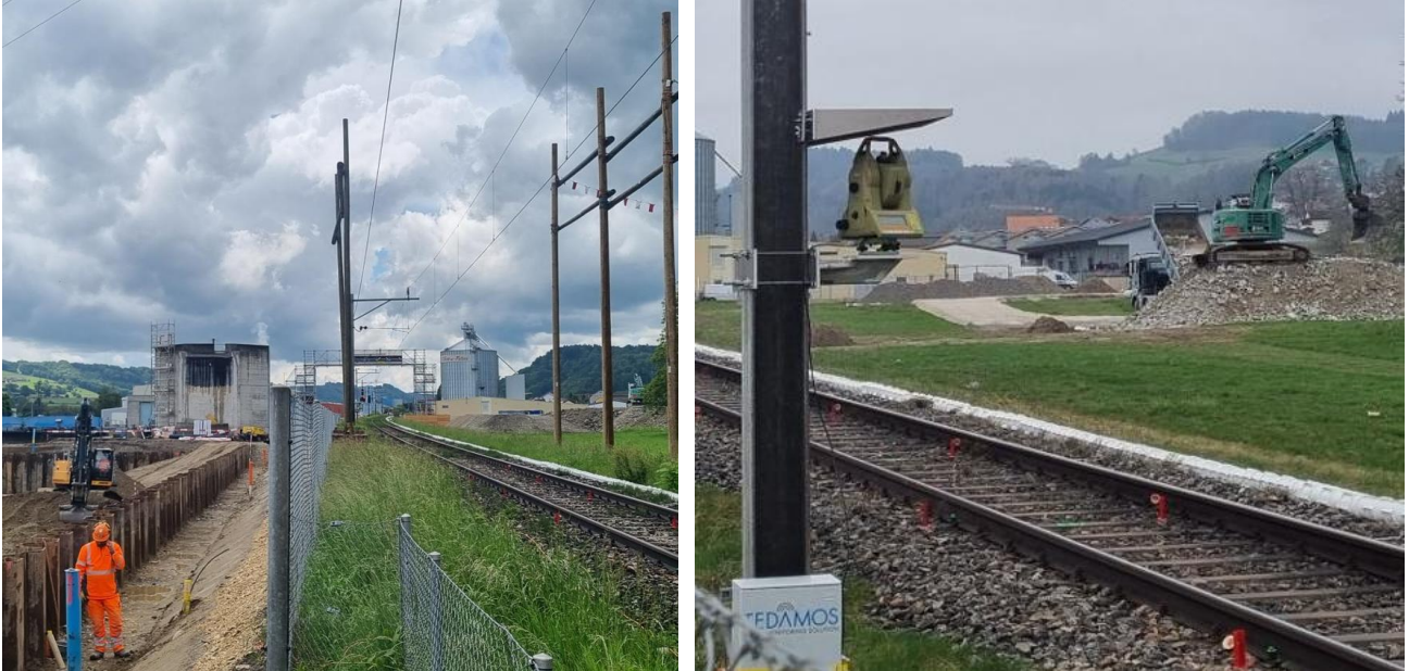
Le chantier, à proximité immédiate des voies. A droite : appareil de mesures surveillant la voie
